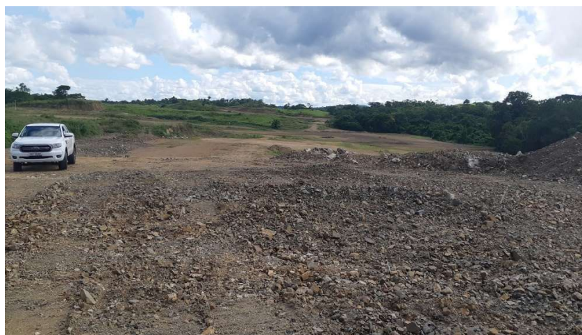
FOTO 03: TERRAPLANAGEM E ESCAVAÇÃO DA 2ª FASE – ETAPA 1..
