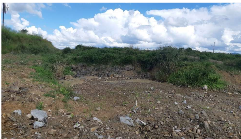
FOTO 05: TERRAPLANAGEM DA 2ª FASE – ETAPA 1.
