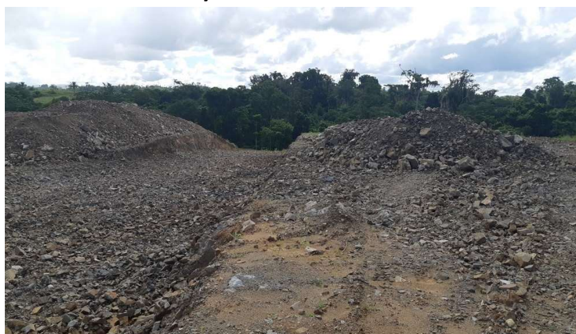
FOTO 02: ESCAVAÇÃO DE MATERIAL DA 2ª FASE – ETAPA 1
