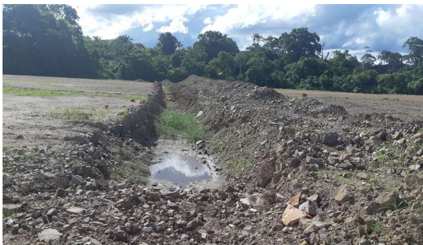
FOTO 16: ESCAVAÇÃO DE MATERIAL DA 2ª FASE – ETAPA 1.
