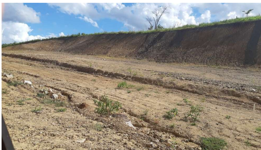
FOTO 14: TERRAPLANAGEM DA 2ª FASE – ETAPA 1.
