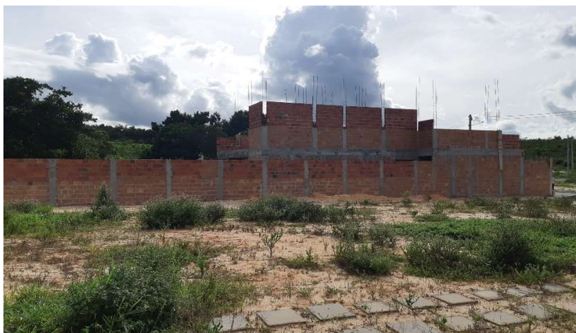
FOTO 46: CASA EM CONSTRUÇÃO NO EMPREENDIMENTO.
