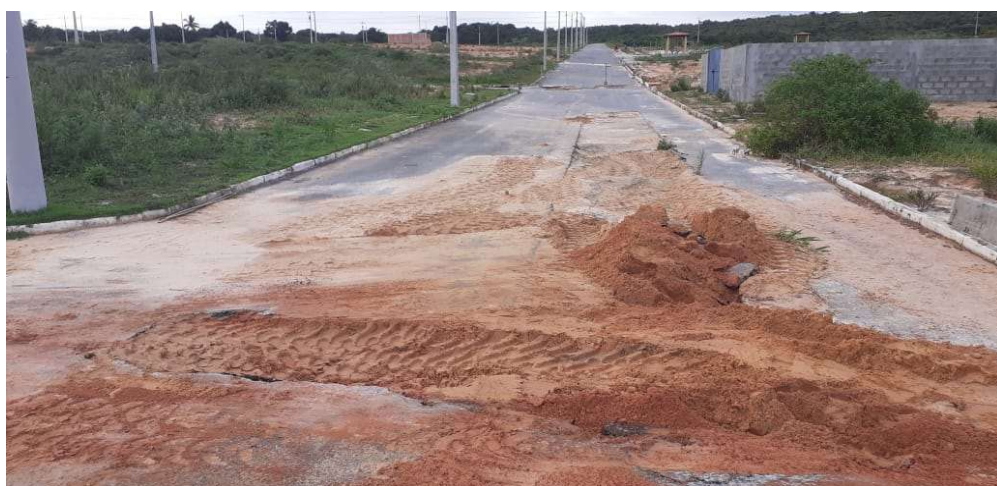
FOTO 51: RUA 2 COM REPARO NA REDE DE ÁGUA POR CONTA DA EMPREENDEDORA METRO.
