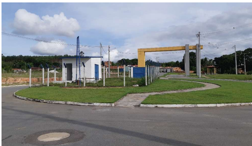
FOTO 04: LOCAL DESTINADO AO POÇO TUBULAR E CAIXAS DE PASSAGEM DA TUBULAÇÃO EXISTENTE.
