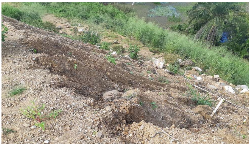
FOTO 07: ESCAVAÇÃO DE MATERIAL DA 2ª FASE – ETAPA 1.
