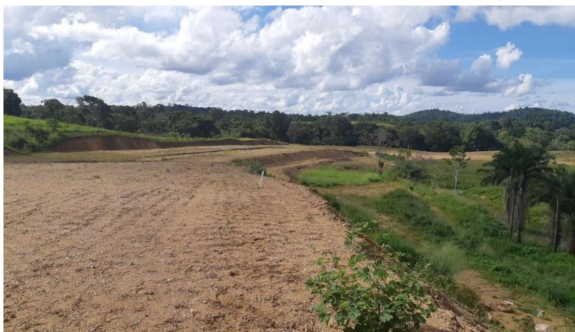
FOTO 12: TERRAPLANAGEM E LIMPEZA DA 2ª FASE – ETAPA 1.
