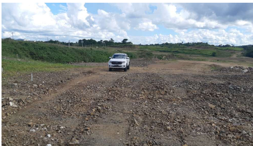
FOTO 17: TERRAPLANAGEM E LIMPEZA DA 2ª FASE – ETAPA 1.
