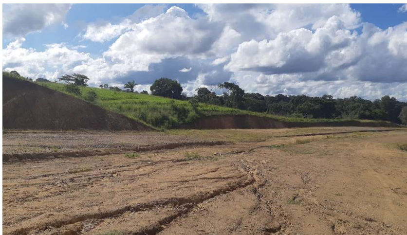
FOTO 13: TERRAPLANAGEM DA 2ª FASE – ETAPA 1.
