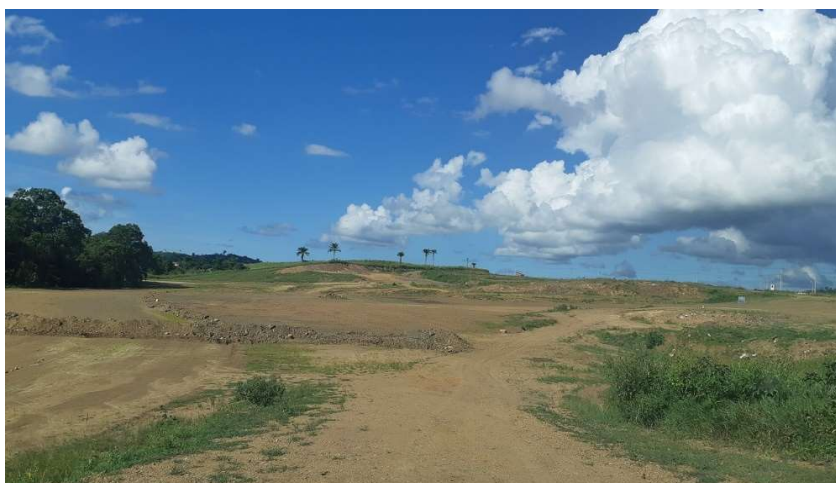
FOTO 15: TERRAPLANAGEM E LIMPEZA DA 2ª FASE – ETAPA 1.
