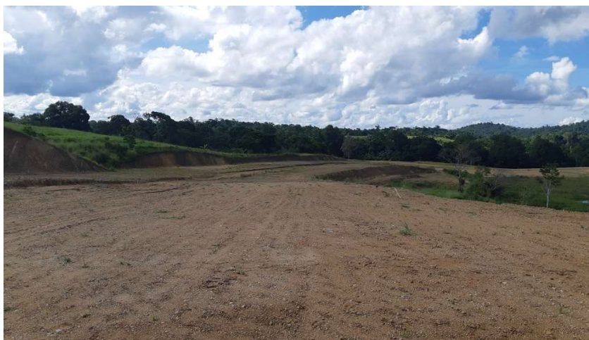
FOTO 06: TERRAPLANAGEM E LIMPEZA DA 2ª FASE – ETAPA 1.
