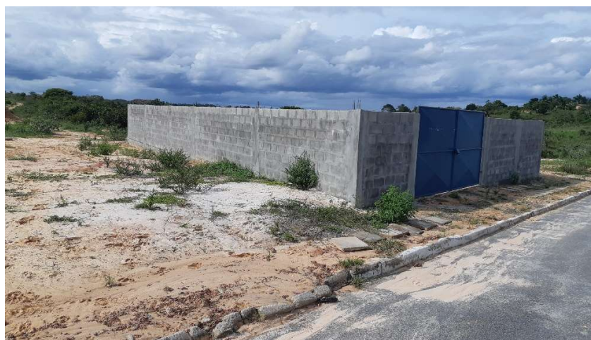
FOTO 08: ESTAÇÃO ELEVATÓRIA DE ESGOTO BRUTO.
