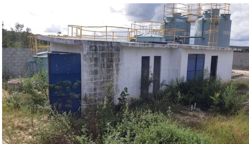
FOTO 09: ESTAÇÃO COMPACTA DE TRATAMENTO DE ESGOTO SANITÁRIO.
