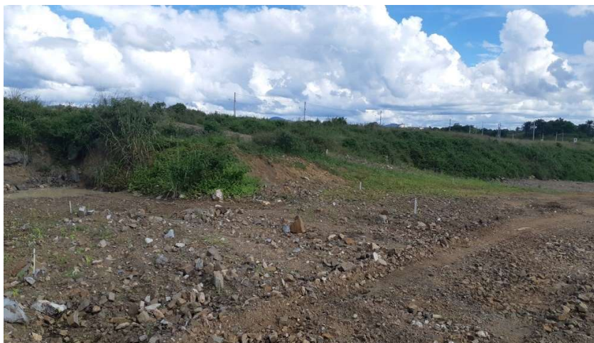
FOTO 04: TERRAPLANAGEM DA 2ª FASE – ETAPA 1.
