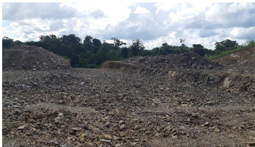
FOTO 01: ESCAVAÇÃO DE MATERIAL DA 2ª FASE – ETAPA 1.
