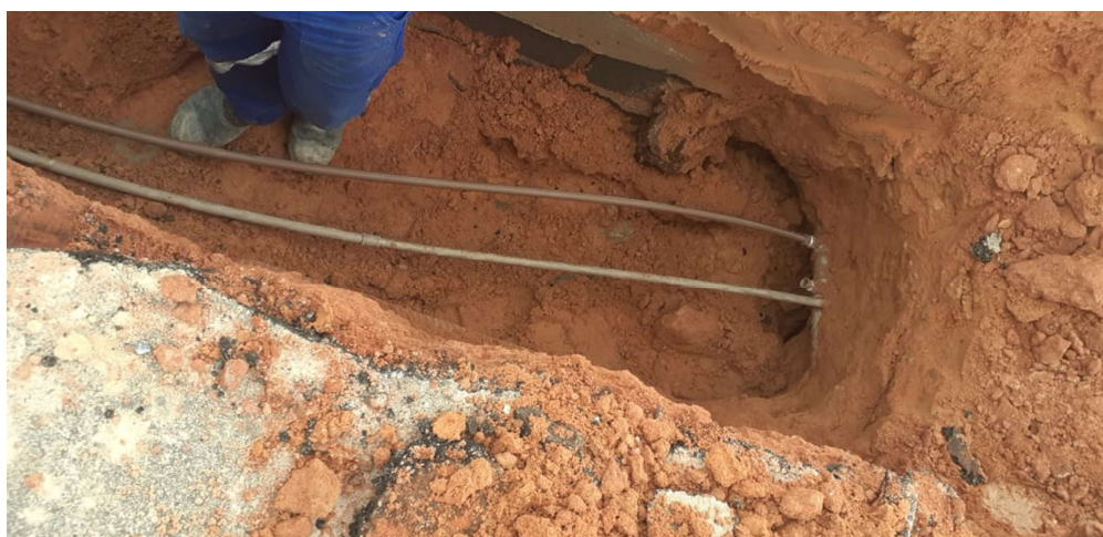
FOTO 50: RUA 2 COM REPARO NA REDE DE ÁGUA POR CONTA DA EMPREENDEDORA METRO.
