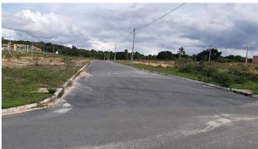
FOTO 41: RUA C3 –BOCAS DE LOBO.
